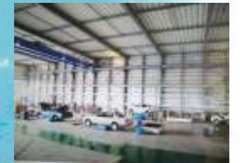
2.9t天井クレーン及び部品取りブース
