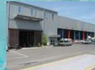
工場正面及び50tトラックスケール
