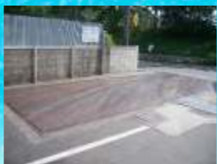
40t トラックスケール
